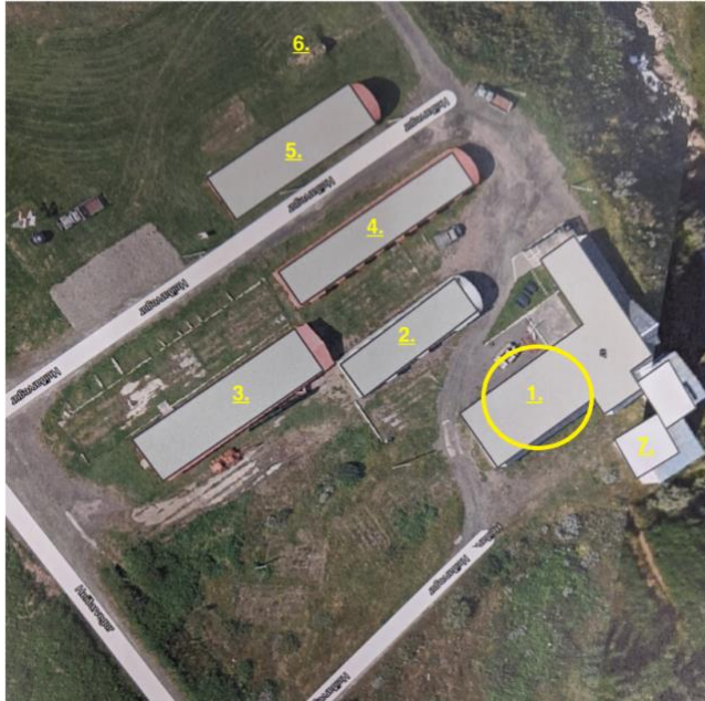
Mynd 27. Staðsetning eldhúsaðstöðu.
